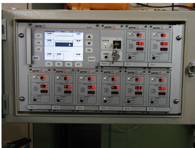
Kontrollschrank des „Artis“ In-Prozess-Meßsystems mit Visualisierungsmöglichkeit jeweils einer Bearbeitungs- kurve und Justierbarkeit der Akzeptanzbereiche Direkte Anzeige der Fehler auslösenden Spindel In Verbindung mit automatischen Entnahmesystem werden fehlerhafte Werkstücke direkt über eine Schub- lade oder eine Rutsche ausgesondert
